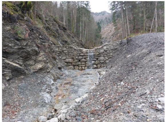
Fotografija 6: Pogled na hudourniško pregrado – v zaledju vidni odlomni robovi (5.1.2024).
